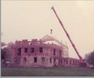
Dachstuhl über dem Saal von Haus Martin – 3 Monate vor dem Richtfest im Dezember 1982
